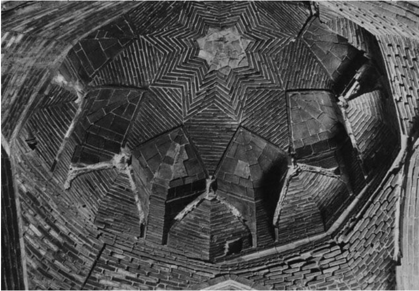
لوحة رقم ٨. نموذج من القباب في بيت الصلاة تبين التشكيلات الهندسية بواسطة الأجر (مسجد الجمعة في أصفهان)
